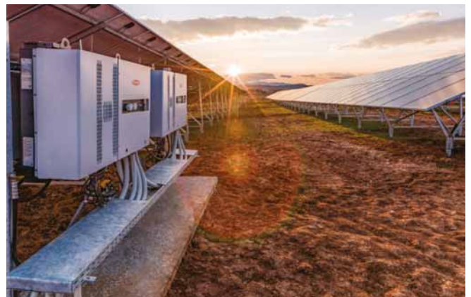
Instalación del Fronius Tauro en Grecia
