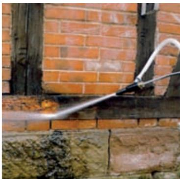
La instalación de chorreado puede montarse fácilmente en la lanza de la limpiadora de alta presión de Kärcher. El detergente para pulverización correspondiente se aspira, se absorbe junto con el chorro de agua y se esparce con un potente efecto abrasivo. Ideal para la eliminación de capas de óxido y de pintura y para decapar en componentes de construcción, así como para la eliminación efectiva de grafitos.
