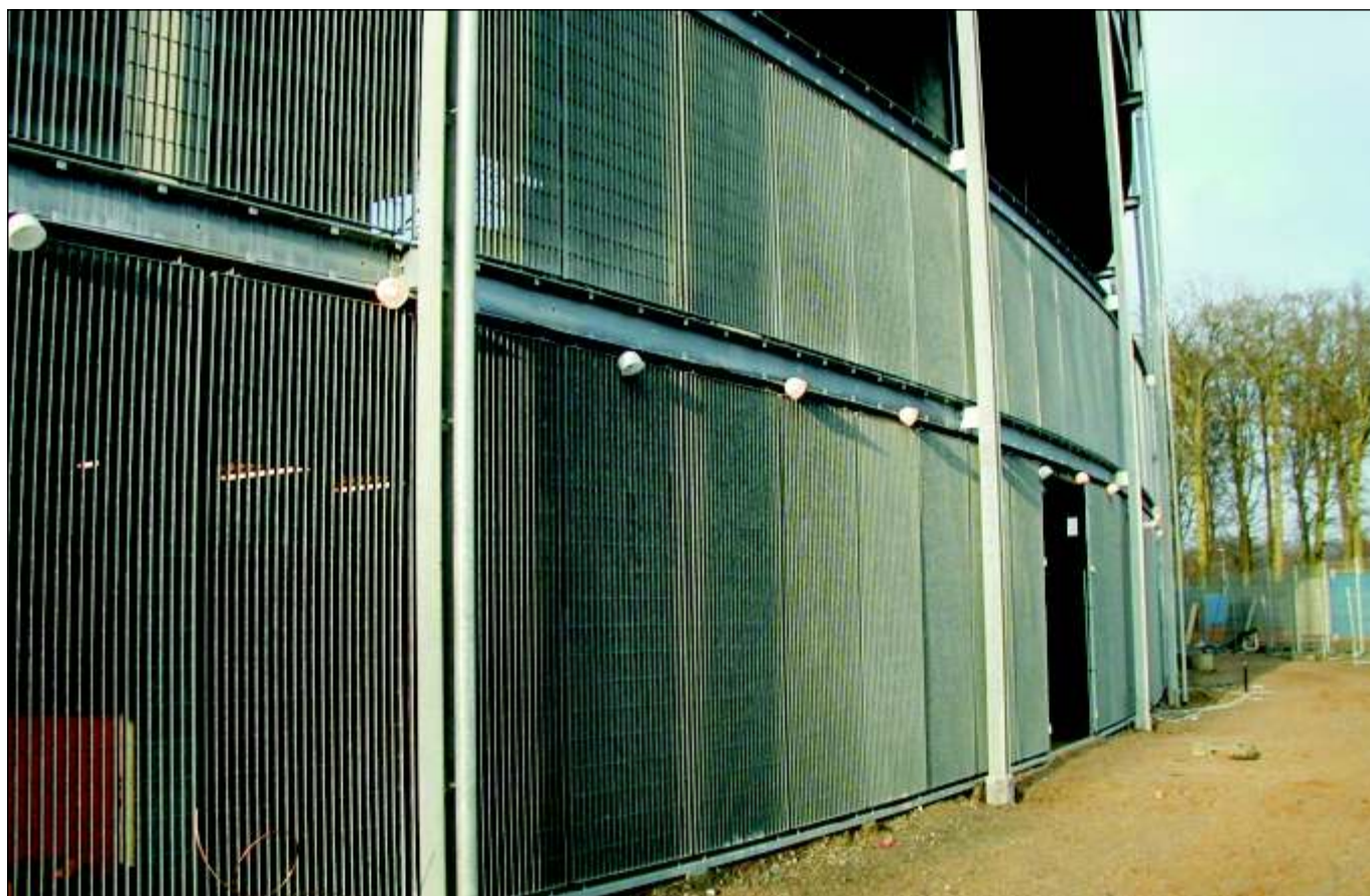
Vista exterior de las rejillas de las paredes de fachada, Estadio de Aarhus, Dinamarca.
