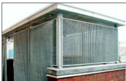
Cobertizo para bicicletas del banco de Jyske Bank, Silkeborg, Dinamarca
