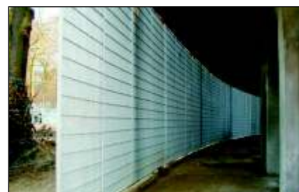
Vista interior de la pared de fachada
