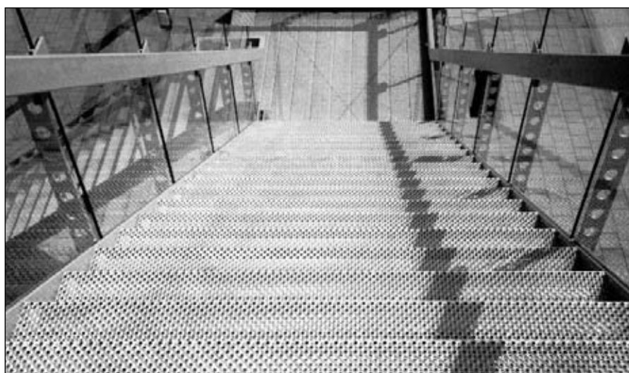
Peldaños seguridad antideslizantes PcP, modelo O2 Achil® y descansillo
