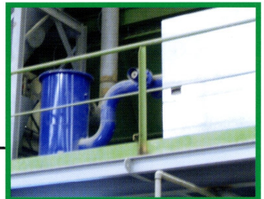
soplante con cabina de insonorización
